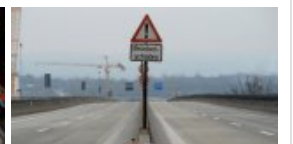
Schiersteiner Brücke bleibt gesperrt
